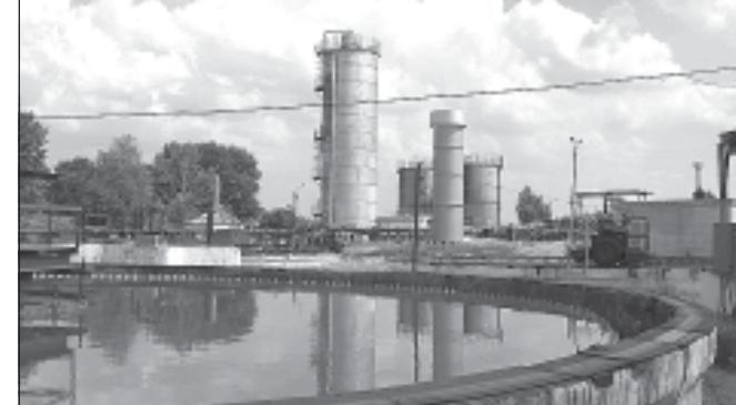
Чтобы минимизировать влияние производственной деятельности комбината на окружающую среду, проводится модернизация очистных сооружений, введенная современная технология биологической очистки сточных вод - анаэробный реактор выведен на проектную мощность 250 м<sup>3</sup> за час
