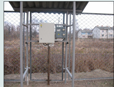
Фото -20: Новоград-Волинська міська рада співфінансувала будівництво насосної станції, яка стала унікальною інвестицією для міста.
