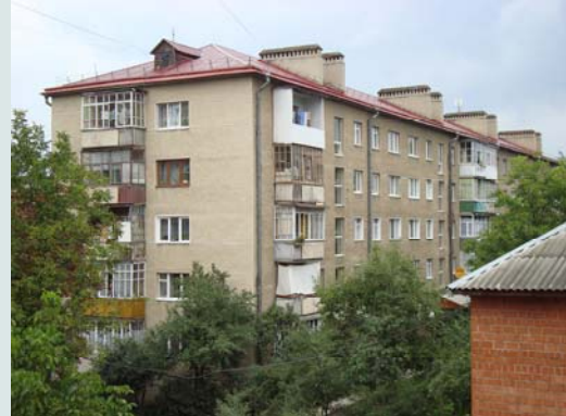
Фото-22: Новий похилий дах захистить 151 мешканця будинку від економічних проблем та проблем із здоров'ям
