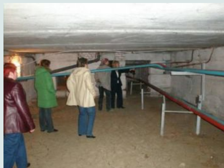
Фото – 27: Громадський аудит нового підвального приміщення ОСББ “Гірник” в м. Кіровське
