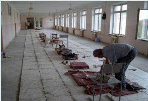
Фото - 24: У процесі роботи по виконанню проекту із заміни покриття підлоги
