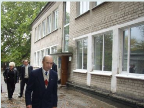
Фото - 6: Нові вікна, встановлені мережею ДНЗ «Натхнення»
