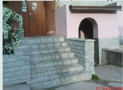
Фото - 14: Відремонтовані під'їзди будинку по вул. Коновальця, 22
