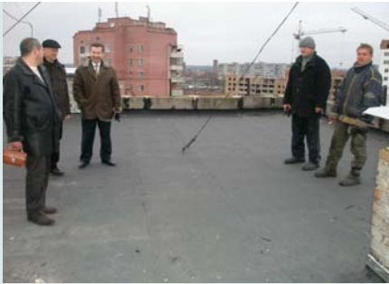
Фото – 12: В процесі реконструкції плаского даху буд. по вул. Шухевича, 2
