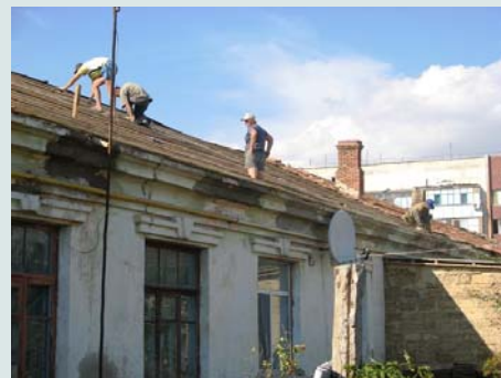
Фото – 9: В процесі ремонту даху.
