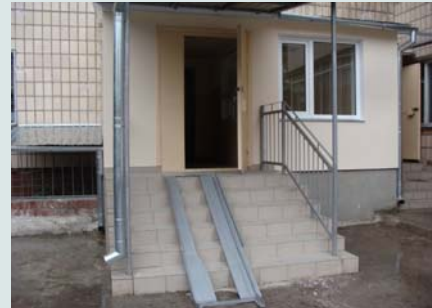
Фото – 12: Капітальний ремонт входів в будинок покращив екологічні, гігієнічні та санітарні умови всередині будинку
