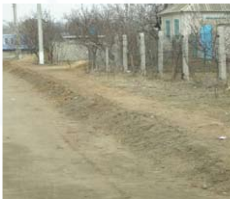
територія після прокладання труб
